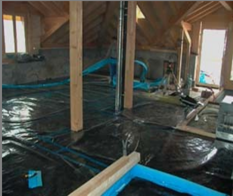
Sanierung Altersheim Obersaxen. Schallschutz mit ofengetrocknetem Sand
