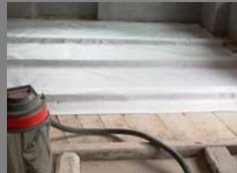
Assainissement d'une résidence pour personnes âgées à Obersaxen. Isolation acoustique avec sable séché au
