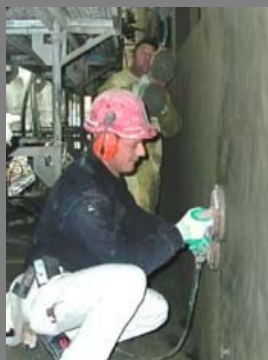
Gewerbeschule Chur, Sanierung. Vollflächige Fassadensanierung mit Brettstruktur, Erdgeschoss.
