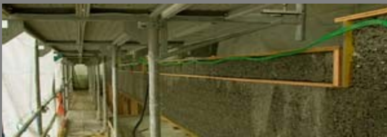
Assainissement de l'école professionnelle à Coire. assainissement de toutes les façades avec structure en planches, rez-de-chaussée
