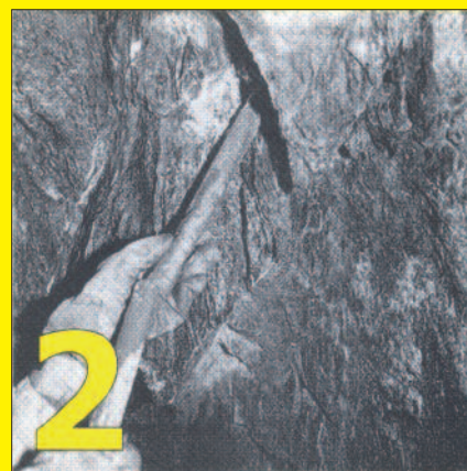
2 Patrone ins Bohrloch führen. Durch einen leichten Stoss des Ladestockes bleibt sie fest sitzen.
